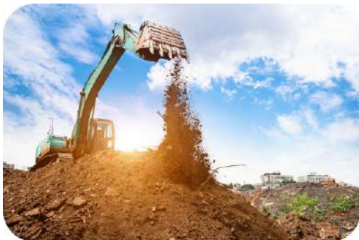
Tiefbau, Fundamente inkl. Beton und Zuleitungen (externer Profiservice)
